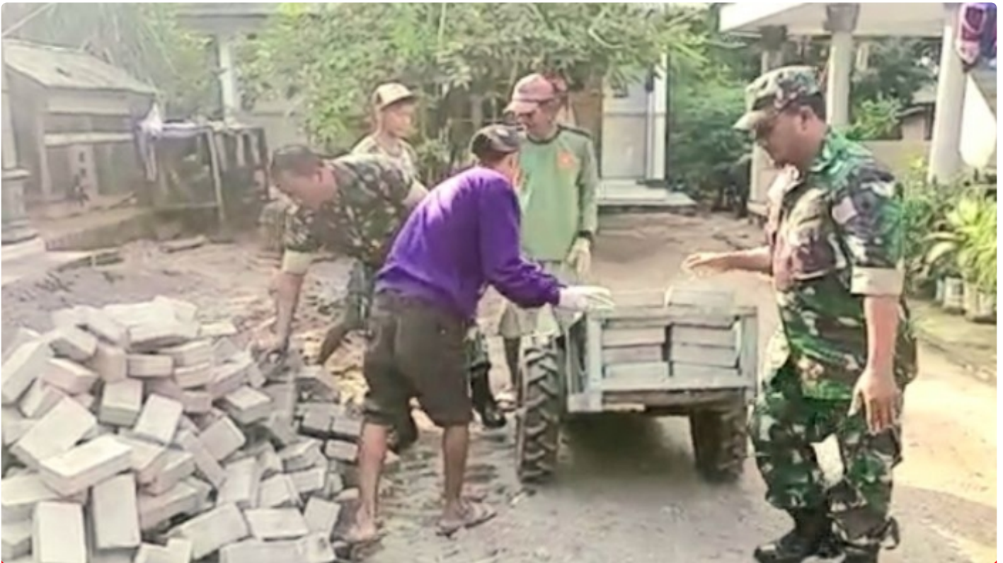
Babinsa Desa Keleyan, Koramil 0829/02 Socah saat membantu warga memperbaiki jalan Desa
