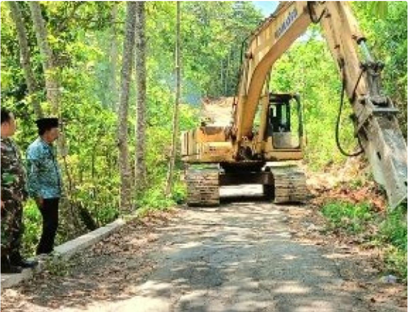
Babinsa Koramil 0829-15/Geger saat Monitoring Perbaikan Jalan di Dusun Cangkreng
